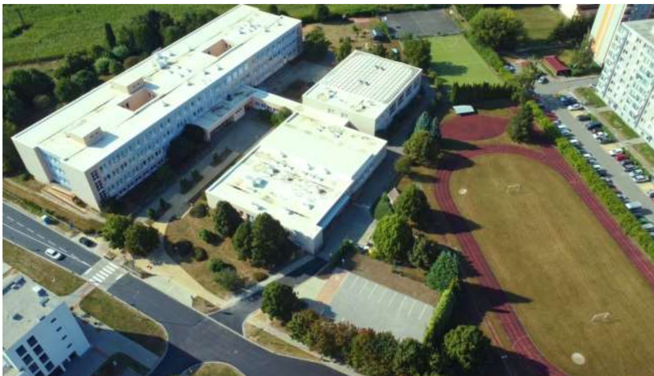
POHLED NA ŠKOLU Z DRONU (HLAVNÍ VSTUP DO BUDOVY, SPORTOVIŠTĚ)
